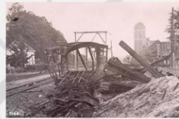
Oisterwijk Ravage aan de Spoorlijn in Oisterwijk.
