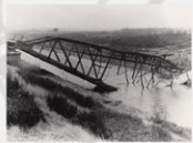
Best In 1944 hebben teruggekende Duitsers de in 1940 weer opgebouwde brug opgeblazen.
