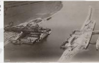
Groot De Grafhe brug in aanbouw in 1928.
